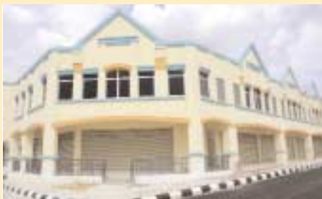
2-storey shop-office at Pusat Bandar Bangi / Kedai-pejabat 2-tingkat di Pusat Bandar Bangi
