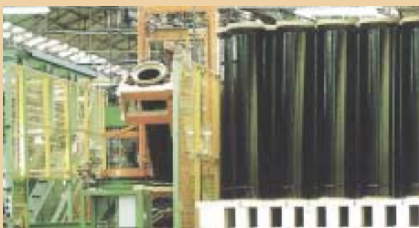
Keramo's vitrified clay pipe production plant / Kilang pengeluaran paip tanahliat kekaca Keramo
